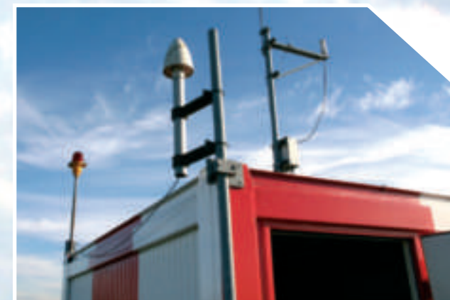
Position der aviationGATE-Sendeanlagen auf dem Braunschweiger Flughafen
